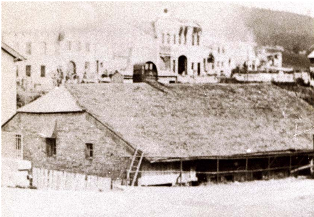
Incendie du village des Charbonnières survenu dans la nuit du 10 au 11 septembre 1900. Les ruines sont encore fumantes. Au premier plan ce bon Vieux Moulin, propriété de la famille Charles Rochat dit Tcherlu. La famille habite encore à cette époque cette vieille bâtisse, avec notamment Marcel Rochat du Moulin et sa sœur Annette.
